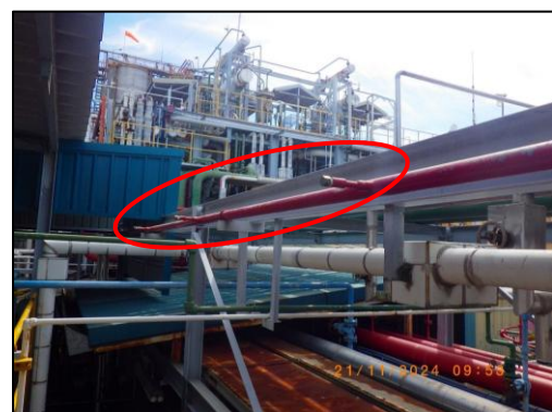
รูปที่ 3.79 Springkler Water Spray บริเวณกระบวนการผลิตเม็ดพลาสติกโพลีเอทิลีน
