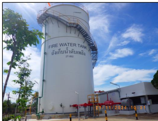
รูปที่ 3.61 ถังสำรองน้ำดับเพลิงคอนกรีต ขนาด 2,616 ลูกบาศก์เมตร
