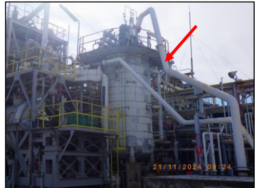
รูปที่ 3.103 ระบบระบายก๊าซฉุกเฉิน บริเวณถัง R2
