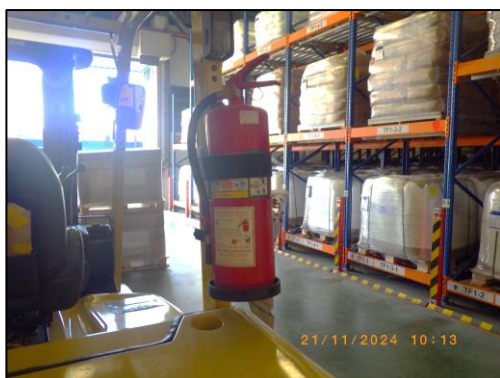
รูปที่ 3.66 ถังดับเพลิง ชนิดผงเคมีแห้งแบบมือถือ บริเวณรถโฟล์คลิฟท์
