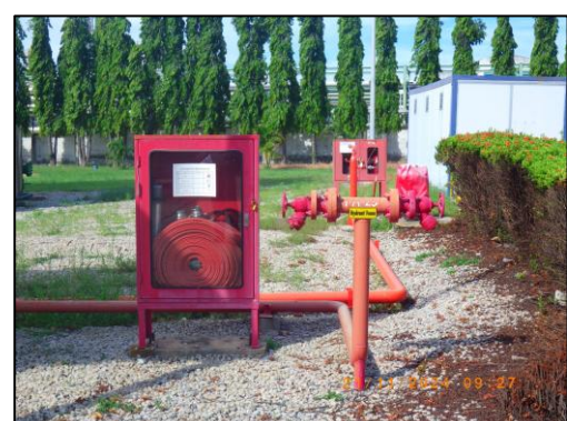
รูปที่ 3.73 Foam Hydrant & Hose Cabinet (FH) บริเวณพื้นที่กระบวนการผลิต
