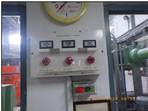
รูปที่ 3.86 ระบบควบคุมสัญญาณแจ้งเหตุฉุกเฉิน
