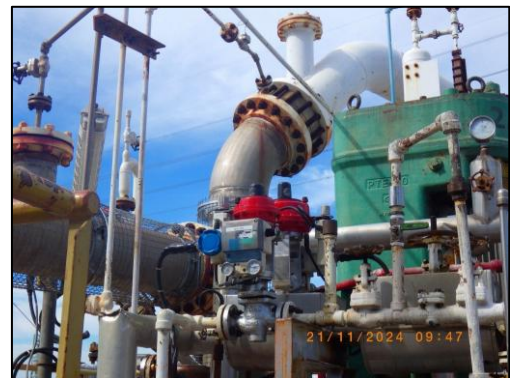
รูปที่ 3.95 Rupture Disc บนถัง R 2
