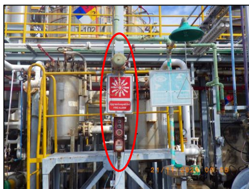
รูปที่ 3.78 สัญญาณเตือนเพลิงไหม้ (Manual Fire Alarm) บริเวณกระบวนการผลิตเม็ดพลาสติกโพลีเอทิลีน
