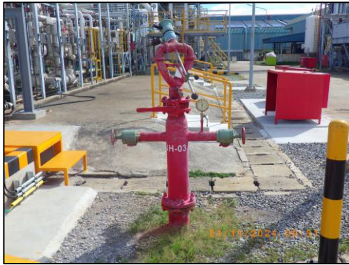
รูปที่ 3.74 Jet Hydrant & Hose (JH) บริเวณพื้นที่กระบวนการผลิต
