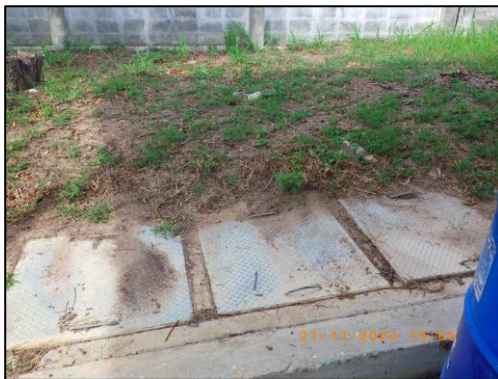
รูปที่ 3.45 บ่อพักน้ำเสีย (Sump Pit) บริเวณพื้นที่อาคารเก็บกากของเสีย
