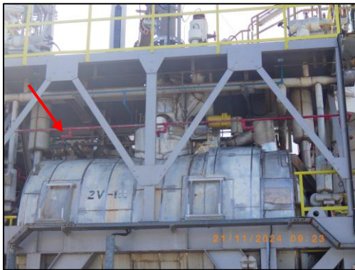
รูปที่ 3.79 Sprinkler Water Spray บริเวณกระบวนการผลิตเม็ดพลาสติกโพลีเอไทรน (ต่อ)
