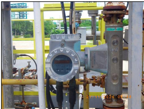
รูปที่ 3.98 Line Flow Indicator บริเวณถัง R1
