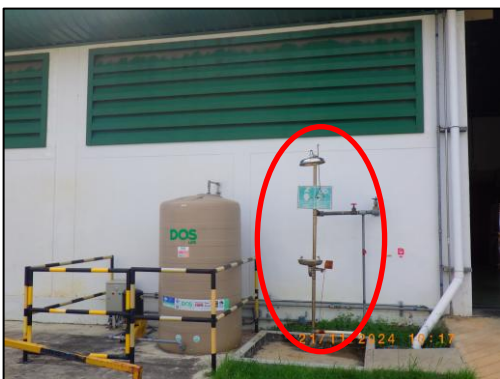
รูปที่ 3.109 ผักบัวล้างตาฉุกเฉิน บริเวณอาคารเก็บสารเคมี
