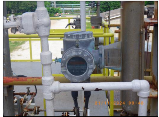
รูปที่ 3.99 Line Flow Indicator บริเวณถัง R2
