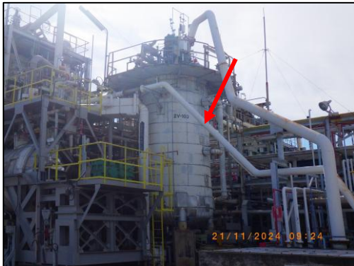
รูปที่ 3.102 ระบบระบายก๊าซฉุกเฉิน บริเวณถัง R1
