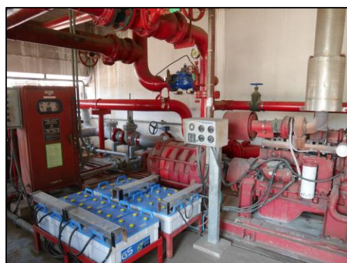
รูปที่ 3.63 เครื่องสูบน้ำดับเพลิง (Firewater Pump) บริเวณอาคาร Fire Pump
